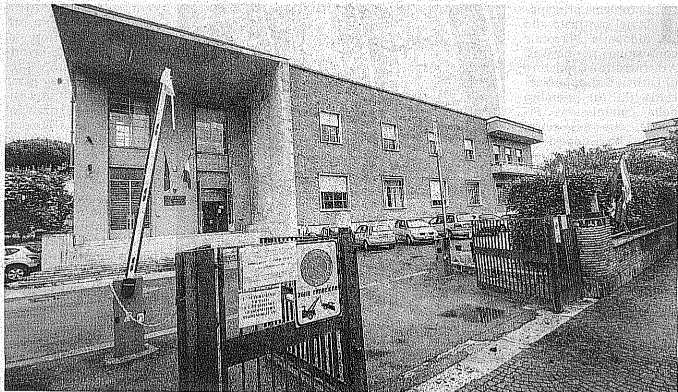
■ La sede di Corso Matteotti del Consorzio di Bonifica dell'Agro Pontino
